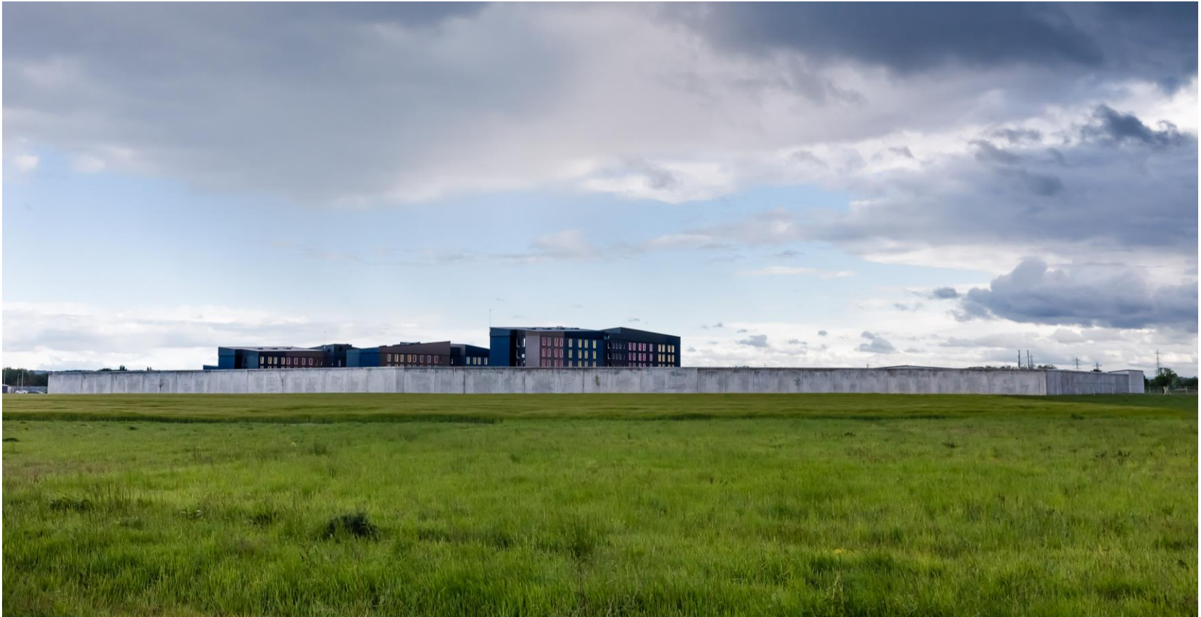
Centre pénitentiaire de Lutterbach
