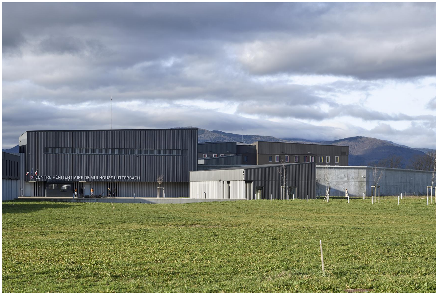
Centre pénitentiaire de Lutterbach
